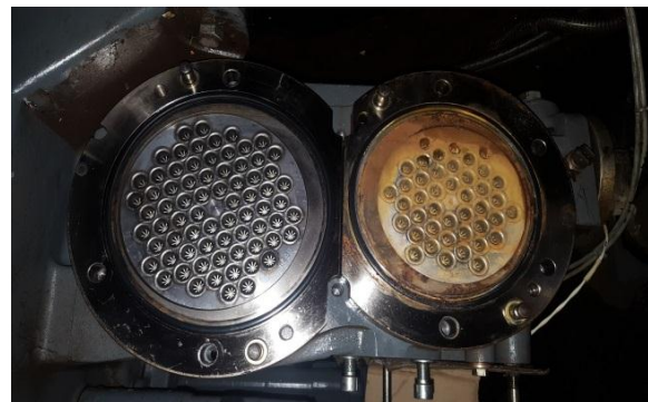
تصویر شماره ۵-۲: وجود آثار زنگ خوردگی در کولر کمپرسور
