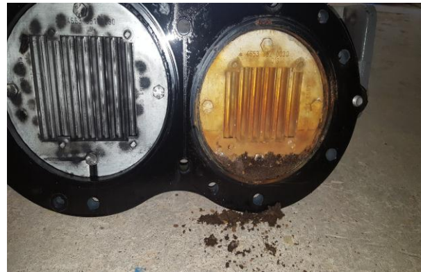
تصویر شماره ۵-۱: وجود آثار زنگ خوردگی در کولر کمپرسور
